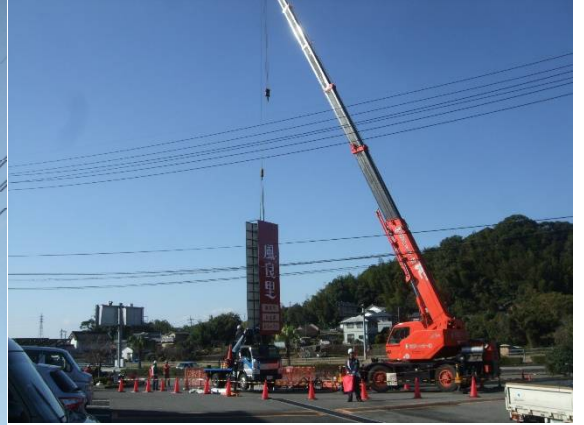
♪ クレーンで釣り上げて設置↓
